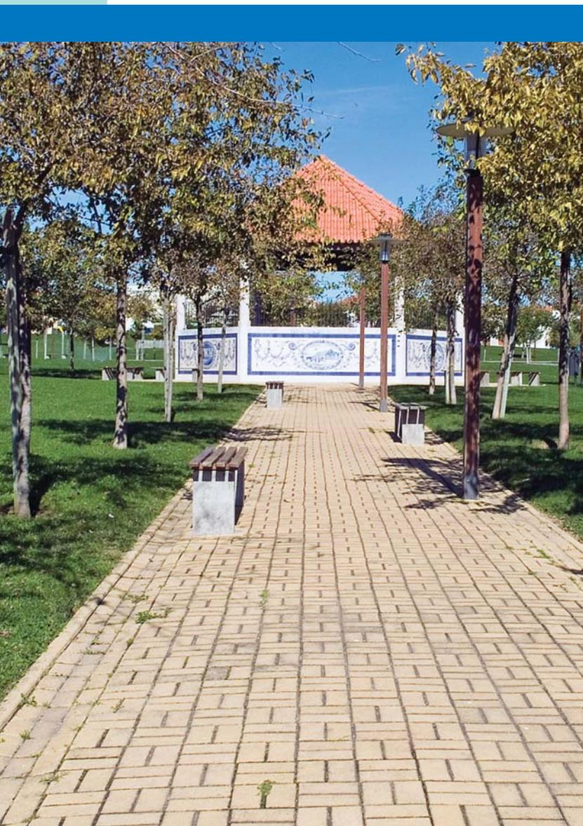
Os Pavimentos em Blocos de Encaixe são caracterizados por uma forte resistência à tracção, compressão e desgaste, tanto a cargas estáticas como dinâmicas.
