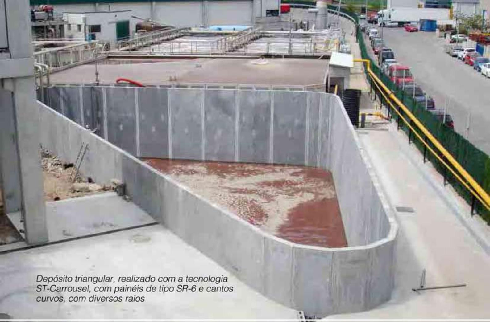
Depósito triangular, realizado com a tecnologia ST-Carrousel, com painéis de tipo SR-6 e cantos curvos, com diversos raios
