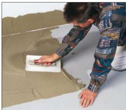
1 ▶ A superfície a ser impermeabilizada deve estar limpa, ser plana e ter capacidade de carga. Corte **Schlüter®-KERDI** com uma tesoura ou com um x-ato para obter as medidas necessárias.
