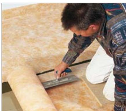
4 ▶ Para os cantos interiores e exteriores pode utilizar as peças moldadas pré-fabricadas **Schlüter®-KERDI-KERECK** e para as passagens de tubos, as guarnições para tubos **Schlüter®-KERDI-KM**.
