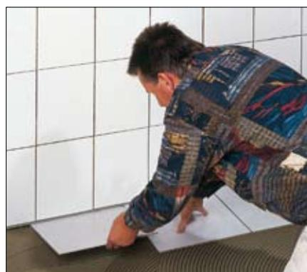
5 ▶ Assim que **Schlüter®-KERDI** for colado como impermeabilização conjunta, pode aplicar o revestimento cerâmico directamente sobre **Schlüter®-KERDI** com uma argamassa fina hidráulica. Não é necessário observar qualquer tempo de espera.
