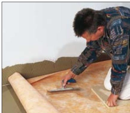
3 ▶ Cole as membranas **Schlüter®-KERDI** umas às outras, sobrepondo-as no mínimo 5 cm. Alternativamente pode colocar as membranas topo a topo e colá-las com uma fita **Schlüter®-KERDI** com 12,5 cm de largura. Para colar as áreas das juntas e as sobreposições pode utilizar a cola vedante **Schlüter®-KERDI-COLL**. A fita **Schlüter®-KERDI** também é adequada para junções angulares especiais.
