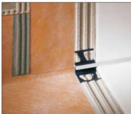
**Schlüter®-KERDI** é uma membrana de impermeabilização de polietileno flexível revestida em ambas as faces por feltro geotextil especial que garante uma excelente aderência do cimento cola. **Schlüter®-KERDI** foi desenvolvido como impermeabilização em conjunto com revestimentos e pavimentos de tijoleira e pedra natural.
