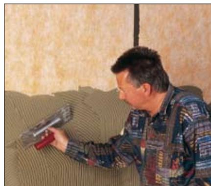
2 ▶ Utilize uma argamassa fina (cola para tijoleira) adequada à superfície para colar a membrana. De forma geral, pode utilizar uma argamassa fina hidráulica disponível no mercado. Aplicar o cimento cola com uma talocha dentada de 4 x 4 mm em toda a superfície da base.
