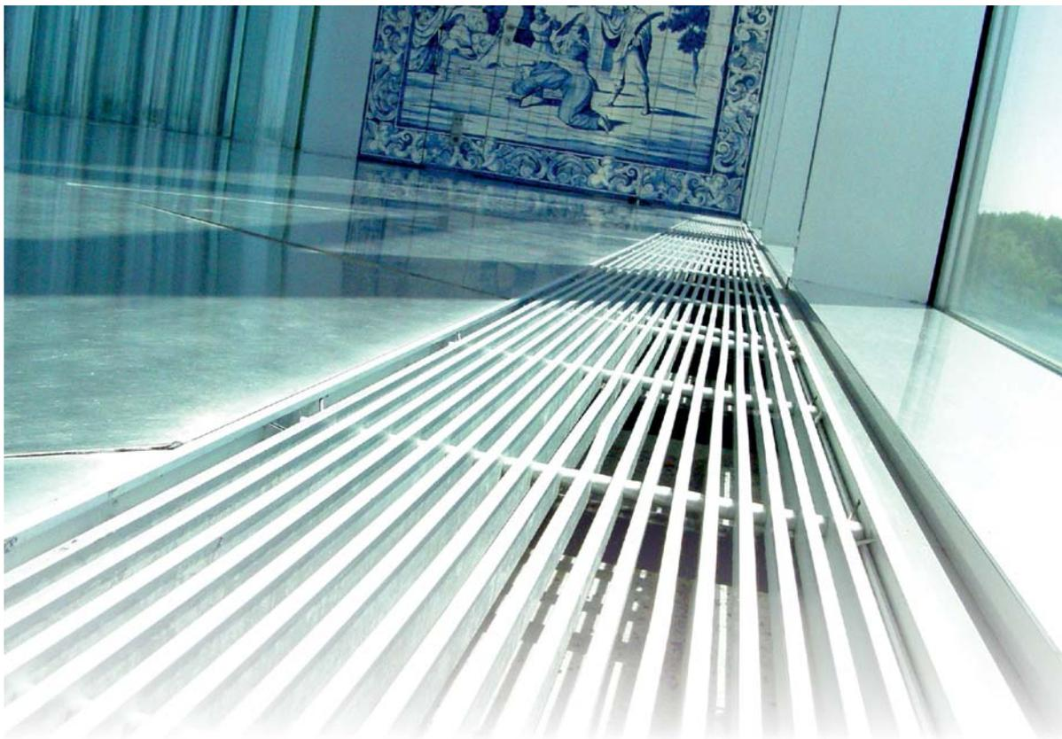
Os elementos terminais de um sistema centralizado de ventilação ou Ar Condicionado (AVAC), como as grelhas ou difusores, constituem o interface visual entre esse próprio sistema AVAC e a arquitectura dos espaços interiores.
