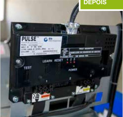
O sistema PULSE monitoriza constantemente o estado das cintas de aço 24 horas por dia, o que constitui um reforço às normas vigentes em matéria de vigilância, manutenção e fiabilidade do seu ascensor.
