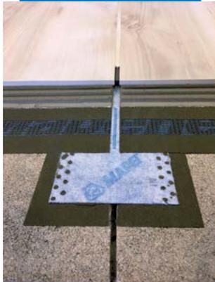
Mapeband Easy aplicado numa junta de controlo na betonilha
