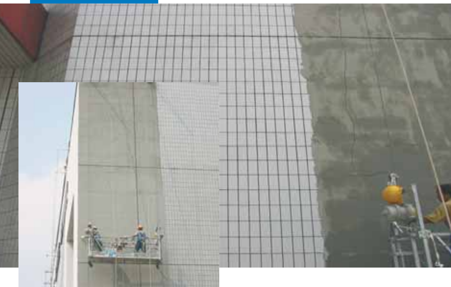
Aplicação de Planitop 200 sobre revestimento em cerâmica
