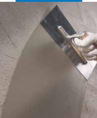
Aplicação de Planitop 200 sobre betão
