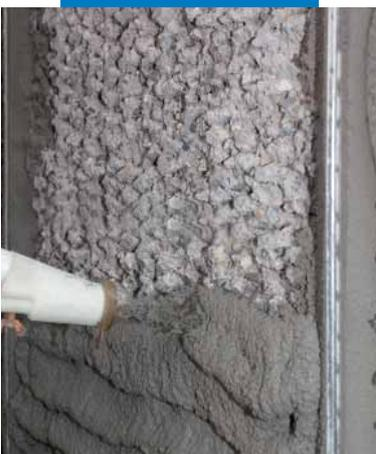
Aplicação com máquina de projetar do Mapegrout 430
