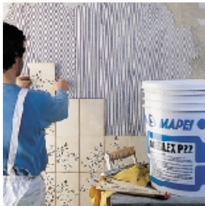
Assentamento sobre reboco normal
