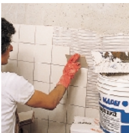
Assentamento sobre parede de betão
