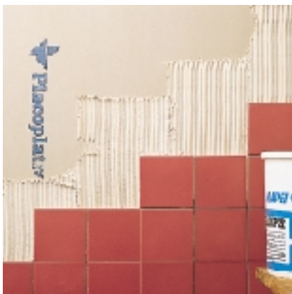
Assentamento sobre gesso cartonado
