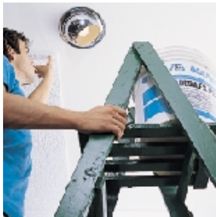
Assentamento de tecto em esferovite
