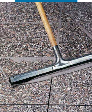
Betumação de pavimento em granito prépolido com rodo
