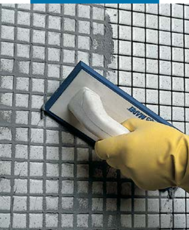
Betumação de revestimento em pastilha de vidro (numa casa de banho) com espátula
