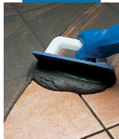
Betumação de pavimento em monocedura com espátula
