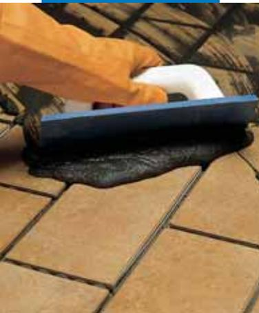
Betumação de juntas de pavimento exterior em klinker com Keracolor GG misturado com Fugolastic
