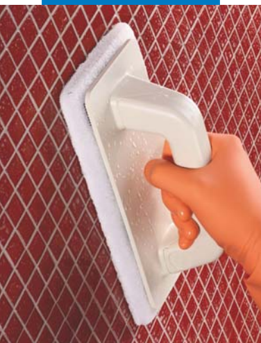
Limpeza da pastilha de vidro com Scotch Brite®
