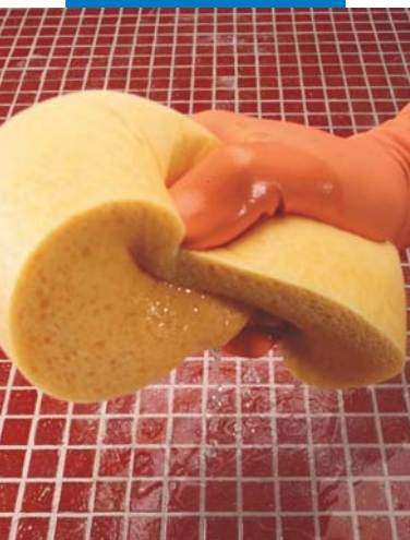
Molhagem da superfície betumada antes da limpeza
