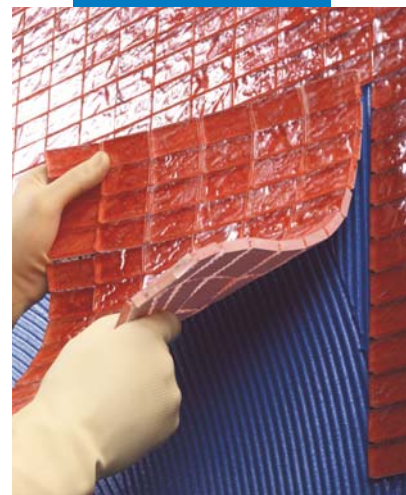
Assentamento de pastilha de vidro na parede com Kerapoxy Design
