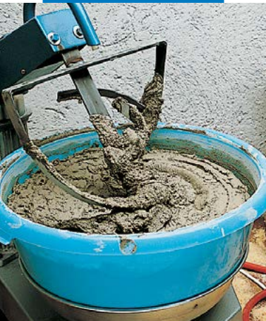
Mistura com mini-betoneira
