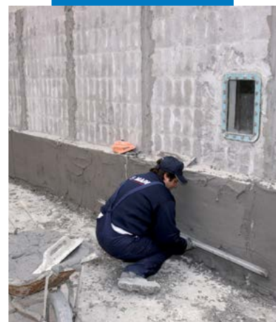
Regularização do reboco com régua
