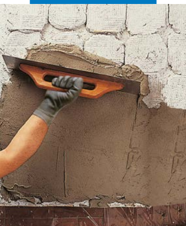
Regularização à talocha
