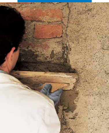
Restauração de alvenaria antiga
