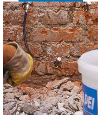
Injeção da mistura com baixa pressão
