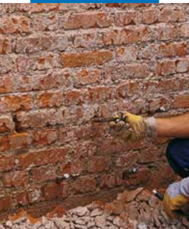
Inserção dos injetores nos furos
