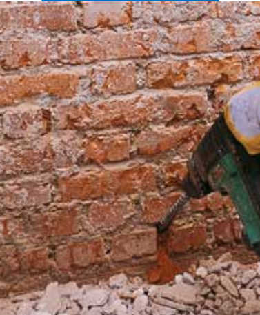
Realização dos furos a quincôncio
