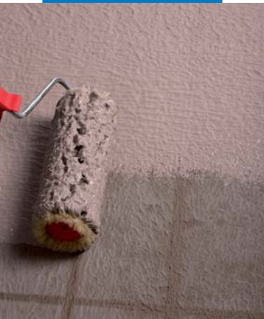
Impermeabilização de terraço a rolo
