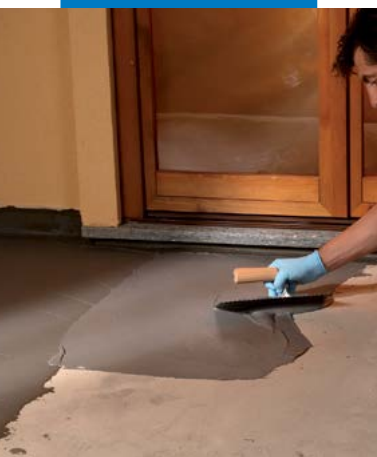
Impermeabilização de terraço com espátula
