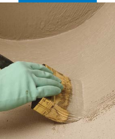
Impermeabilização de detalhes a pincel
