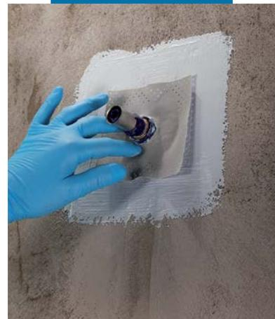
Aplicação de peça especial para furos passantes de **Mapeband PE 120** com **Mapegum WPS**
