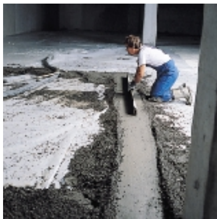
Formação de faixas para nivelamento
