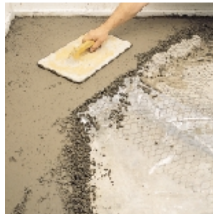
Cobertura dos tubos com MAPECEM e rede de reforço
