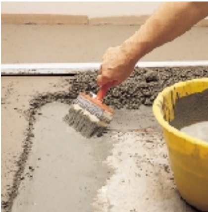
Aplicação da aguada de cimento para ancoragem para massames em MAPECEM aderentes
