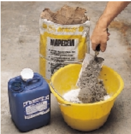
Empaste de MAPECEM com PLANICRETE como aguada de ancoragem
