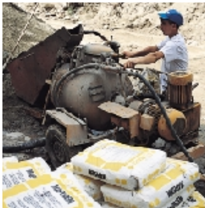
Mistura de MAPECEM com instalação automática de bombeamento
