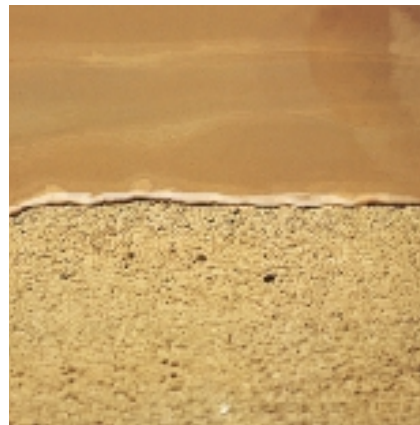
Acabamento de massa em MAPECEM com ULTRAPLAN auto-nivelador
