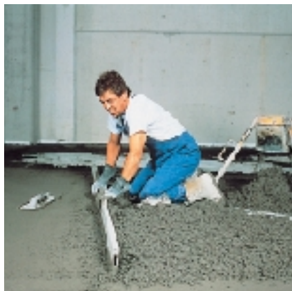
Nivelamento do empaste com MAPECEM
