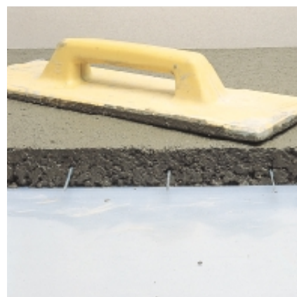
Detalhe de laje de MAPECEM com pedaços de varão para represa
