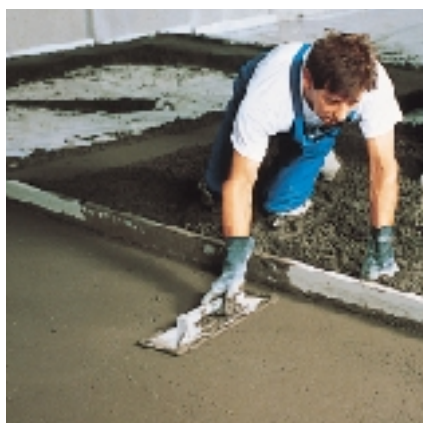
Acabamento com desempenadeira da aplicação do empaste com MAPECEM
