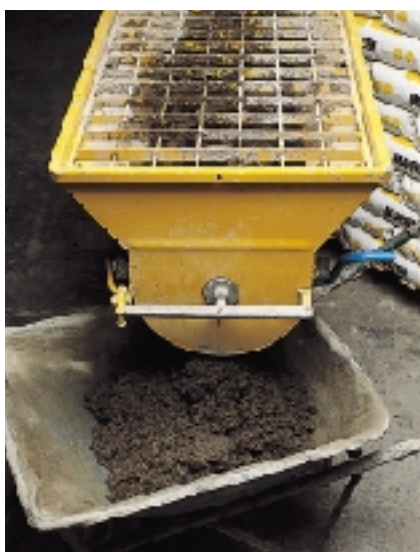
Mistura de MAPECEM com minibetoneira
