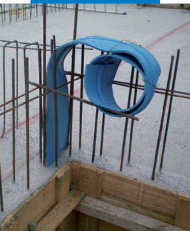
Junta estrutural em parede com perfil em PVC fixado em plateia, com betonagem de plateia já realizada
