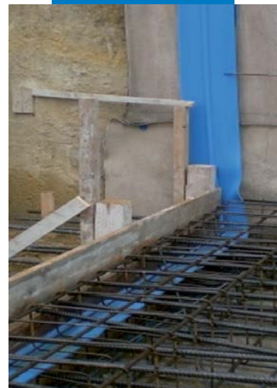
Selagem da junta estrutural em plateia e parede
