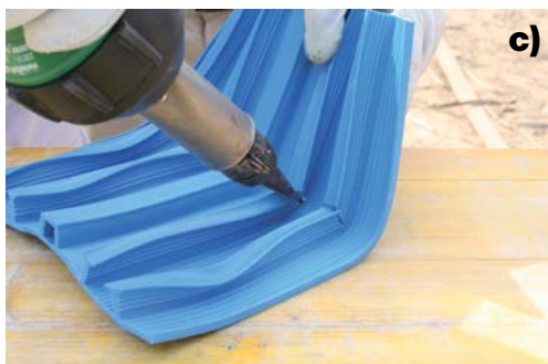
Fases de soldadura a 90° de Idrostop PVC BE: a) corte a 45° das hastes e do bolbo de Idrostop PVC BE; b) as duas abas a soldar são aquecidas com o leister; c) as duas abas são pressionadas uma contra a outra e continua-se a aquece-las com o leister; d) waterstop soldado a 90°
