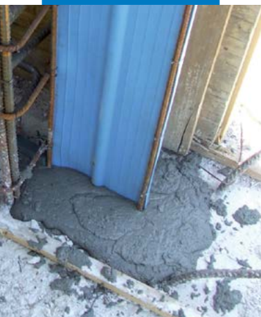
Idrostop PVC BI fixado com Mapegrout Colabile em plateia existente, com prévia demolição de parte da mesma
