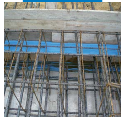
Selagem da junta estrutural em plateia
