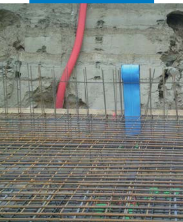
Junta estrutural em parede com perfil em PVC fixado em plateia, antes de proceder à betonagem
