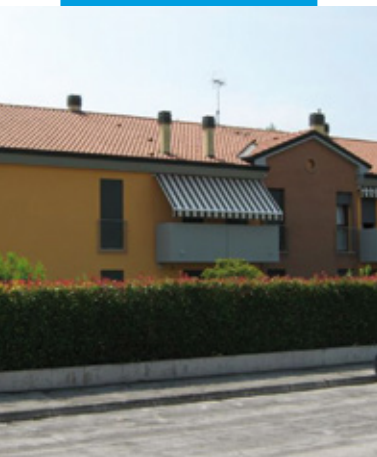
Habitação realizada com Quarzolite Tonachino Plus
