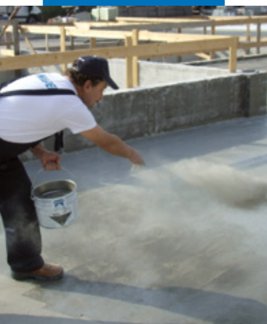
Sprinkling Quartz 0.5 on fresh Primer SN
