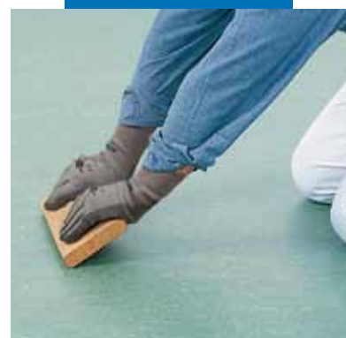
Massagem de junta de linóleo
