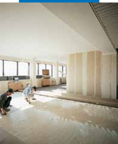
Aplicação de Aquacol T para telas de grande dimensão
