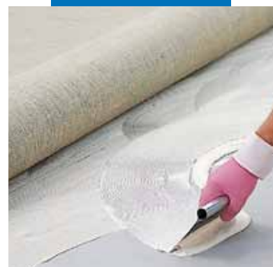
Aplicação de Aquacol T para assentamento de linóleo
