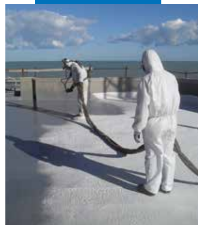
Aplicação de Purtop 400 M sobre Triblock P
