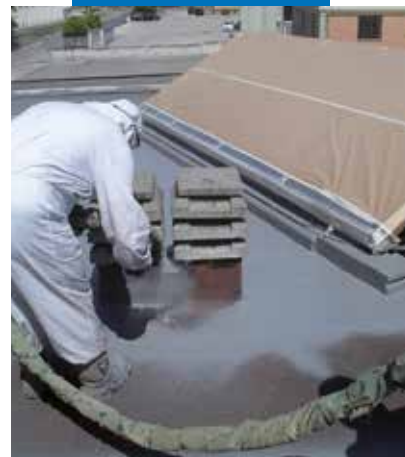
Aplicação de Purtop 400 M sobre membrana betuminosa
