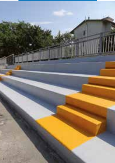
Degraus impermeabilizados com Purtop 400 M finalizado com Mapefloor Finish 55
