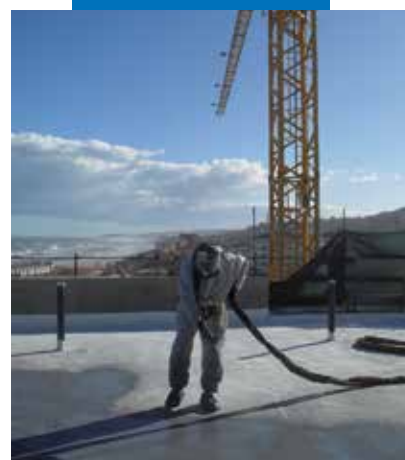
Aplicação de Purtop 400 M sobre Triblock P
