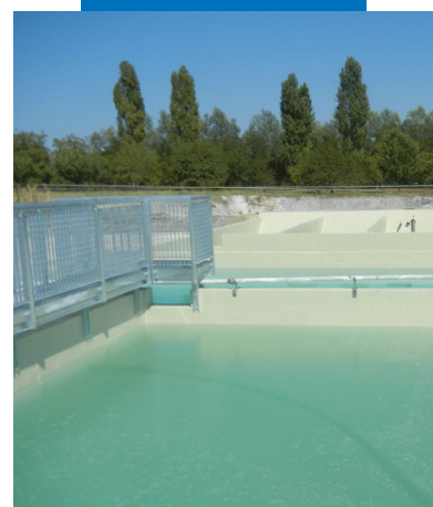
Tanques impermeabilizados com Purtop 1000
