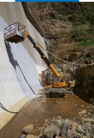
Impermeabilização de um dique
