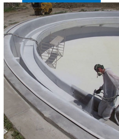
Aplicação de Purtop 1000 em tanques industriais
