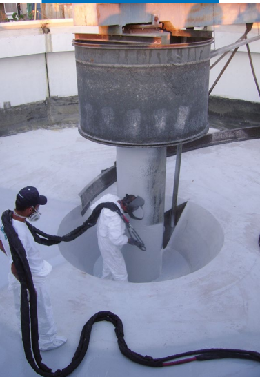
Detalhe de impermeabilização com Purtop 1000 sobre suportes diversos (cimentícios e metálicos)
