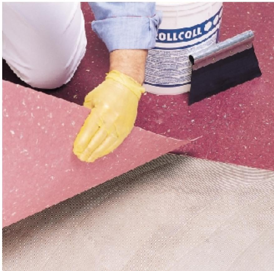
para a utilização de cadeiras de rodas. ROLLCOLL aplicado com rolo ou à pistola permite uma aplicação rápida e uniforme, convenientes especialmente para as grandes superfícies; a película adesiva obtida não contém traços de aplicação com espátula, sendo portanto
