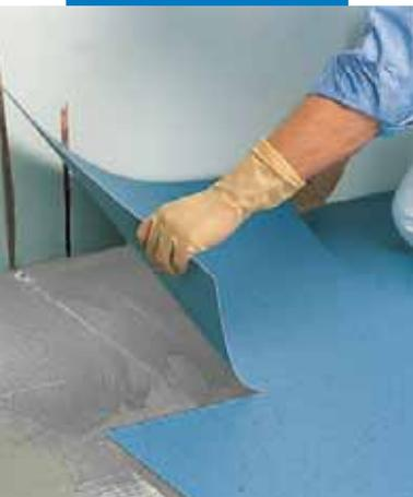
Aplicação de quadrados em PVC conduttivo com Ultrabond Eco V4 Conduttivo
