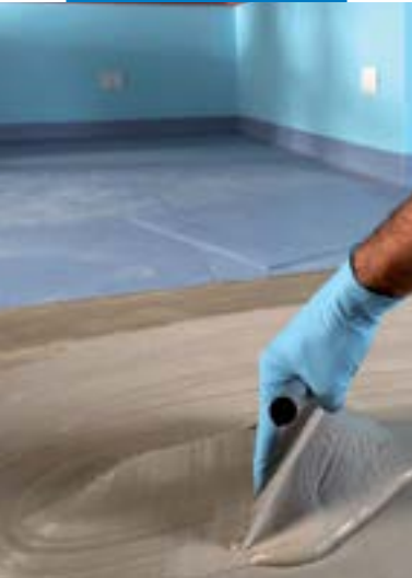
Aplicação de Ultrabond Eco 380
