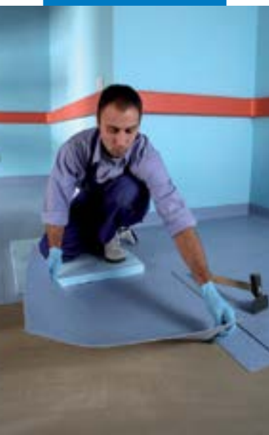
Aplicação em obra do pavimento em ladrilhos de PVC
