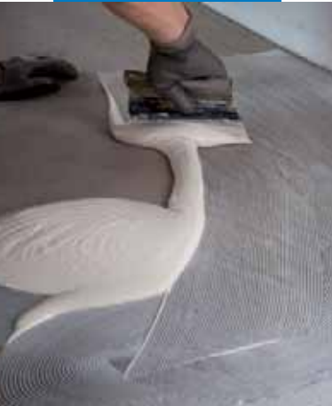
Aplicação de Ultrabond Eco V4 SP Fiber sobre o suporte
