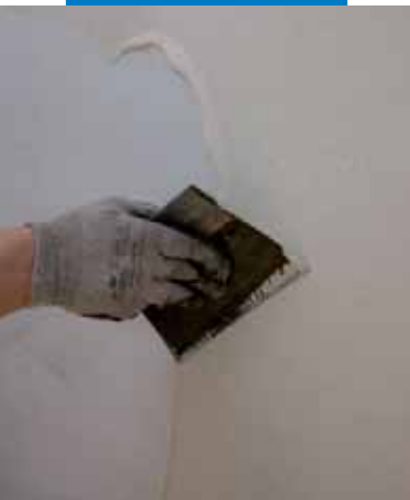
Aplicação de Ultrabond Eco V4 SP Fiber em parede
