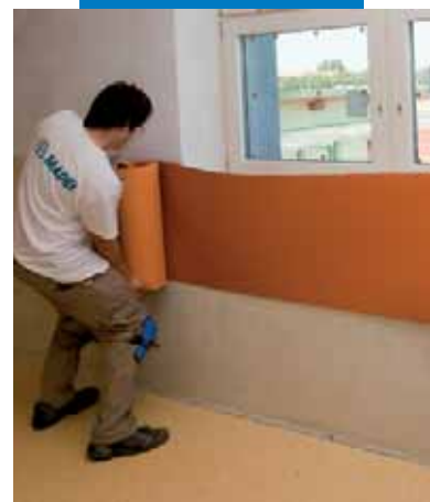
Aplicação em parede de tela de borracha
