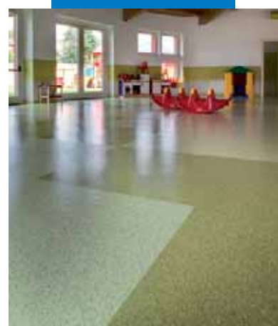
Exemplo de assentamento de borracha numa escola primária: Asilo comunale di Carobbio degli Angeli (BG)
