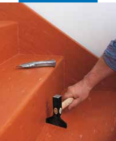
Detalhe da massagem do revestimento em PVC
