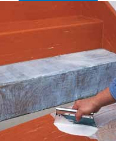
Espalhamento de Ultrabond Aqua-Contact sobre o reverso do revestimento em PVC
