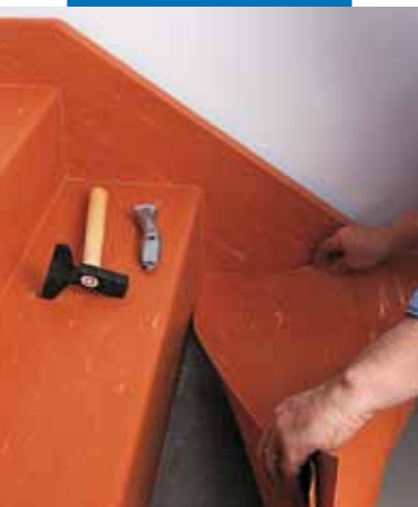
Aplicação do revestimento em PVC
