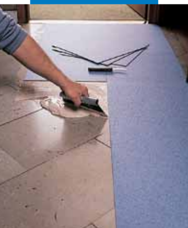
Assentamento de PVC sobre suporte não absorvente com Adesilex G19
