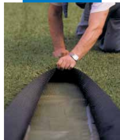
Aplicação de relva sintética com Adesilex G19 - Estádio de S. Siro - Milão (Itália)
