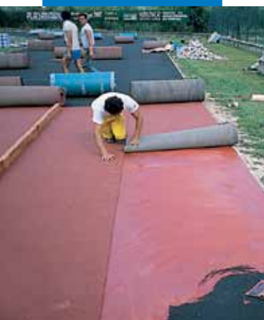
Assentamento de borracha desportiva com Adesilex G19
