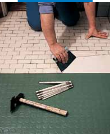
Aplicação do Adesilex G19 com espátula dentada
