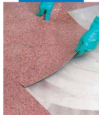
Assentamento de pavimento em PVC com Adesilex G19
