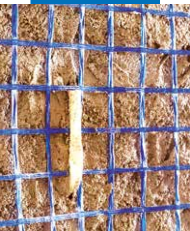
Placing Mapenet EM 40
