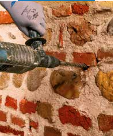
Realização dos furos com Mapenet EM Connector
