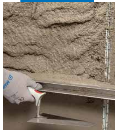
Nivelamento à régua de MapeWall Intonaca & Rinforza
