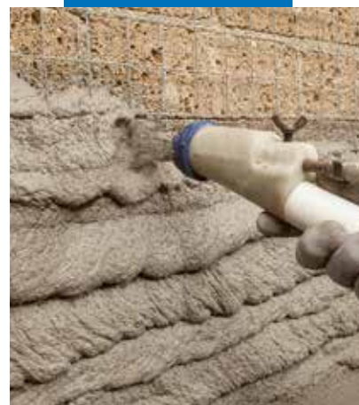
Aplicação de MapeWall Intonaca & Rinforza com máquina de rebocar
