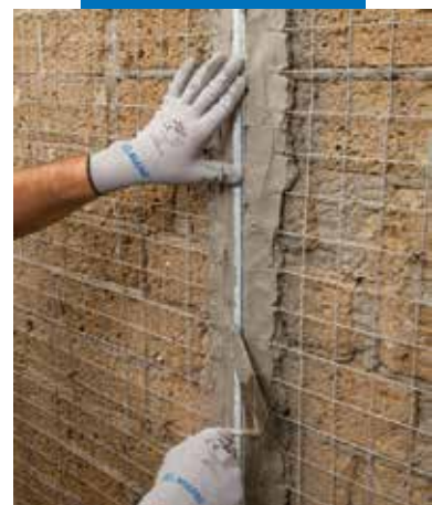
Posicionamento de guias verticais
