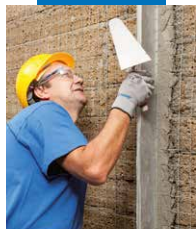
Verificação da verticalidade da guia
