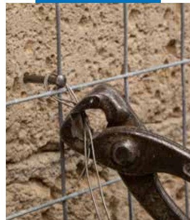
Fixação da rede metálica
