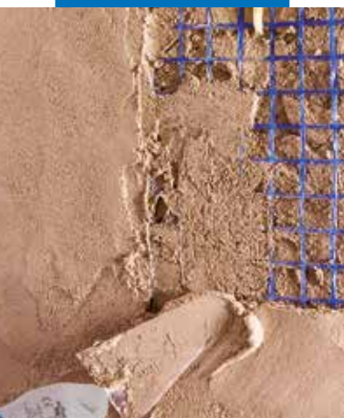
Aplicação do segundo estrato de MapeWall Intonaca & Rinforza
