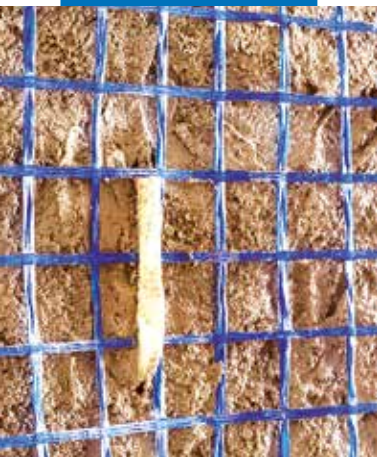
Posicionamento de Mapenet EM 40
