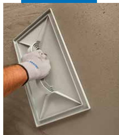
Alisamento da superfície
