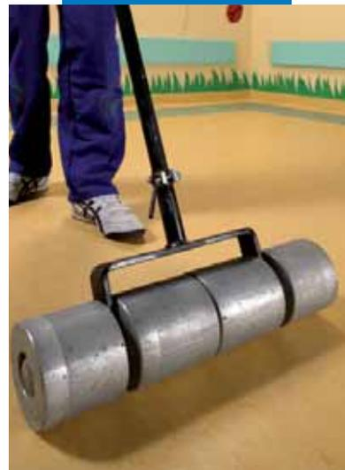
Passagem com o cilindro de peso do pavimento em linóleo
