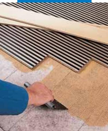
Assentamento de tábuas coloridas sobre pavimento preexistente com Lignobond
