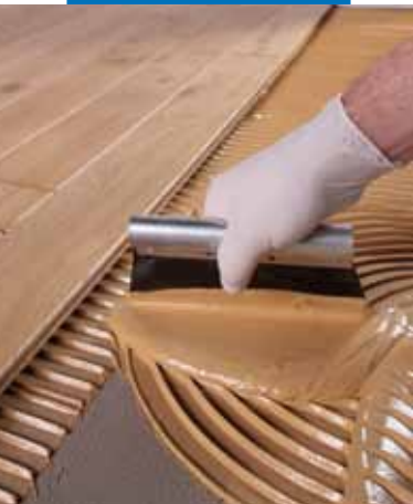
Aplicação de Ultrabond P990 1K
