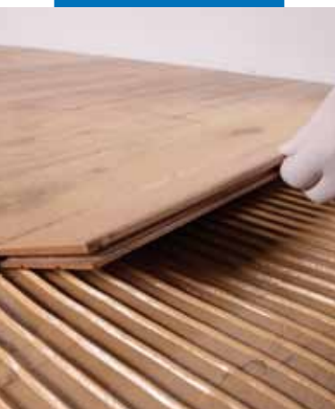
Assentamento do parquet
