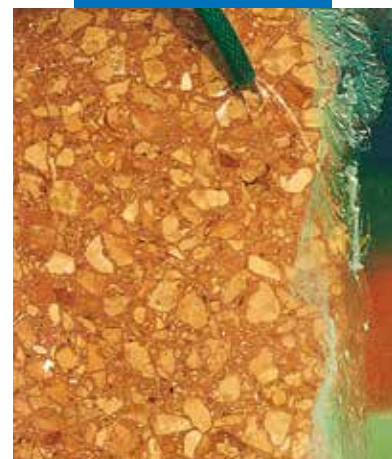
Remoção do graffiti mediante escovagem e lavagem
