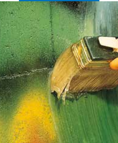
Aplicação de WallGard Graffiti Remover Gel a pincel
