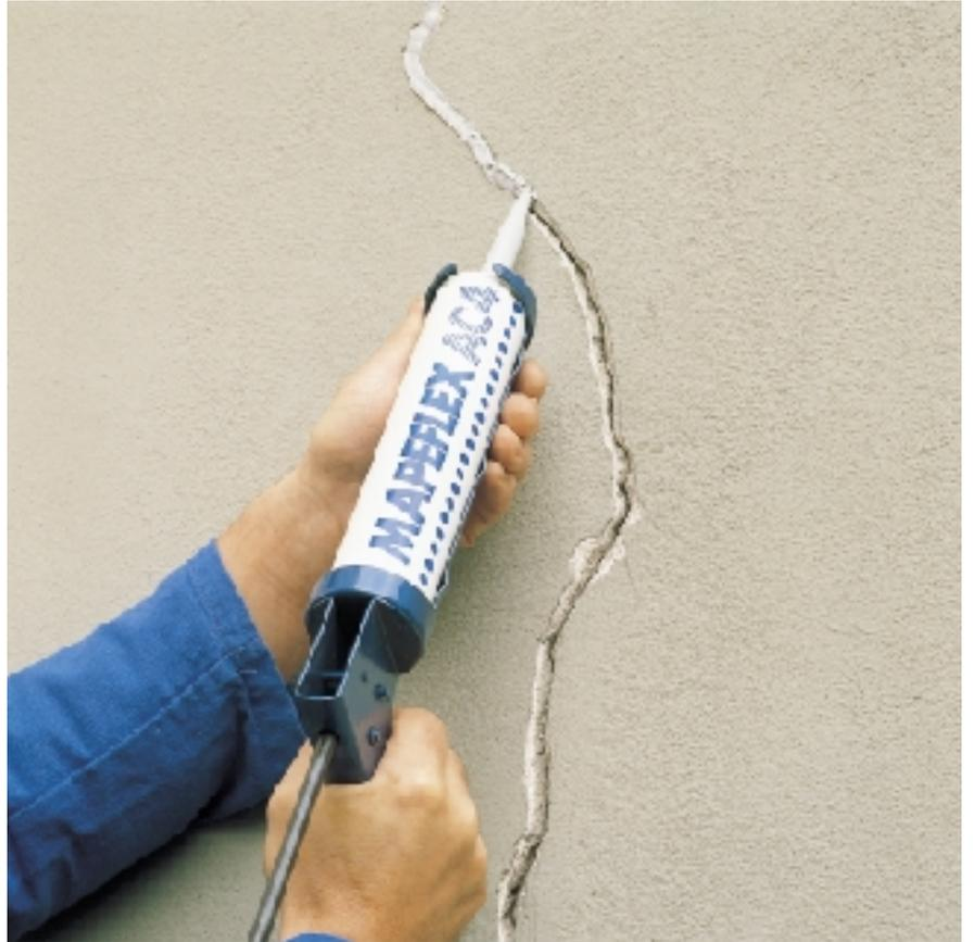
Se a junta com MAPEFLEX AC4 está prevista para umas "contrantes" severas, aconselhamos estender uma camada de PRIMER AC4 sobre as paredes de junta e aplicar MAPEFLEX AC4 2 horas depois.
