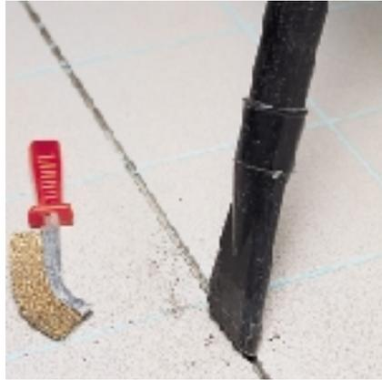
Limpeza do junto mediante aspiração do pó
