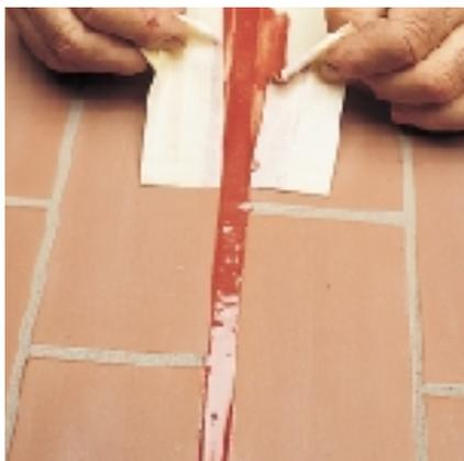
Junto de dilatação de grés vermelho com MAPEFLEX PU21
