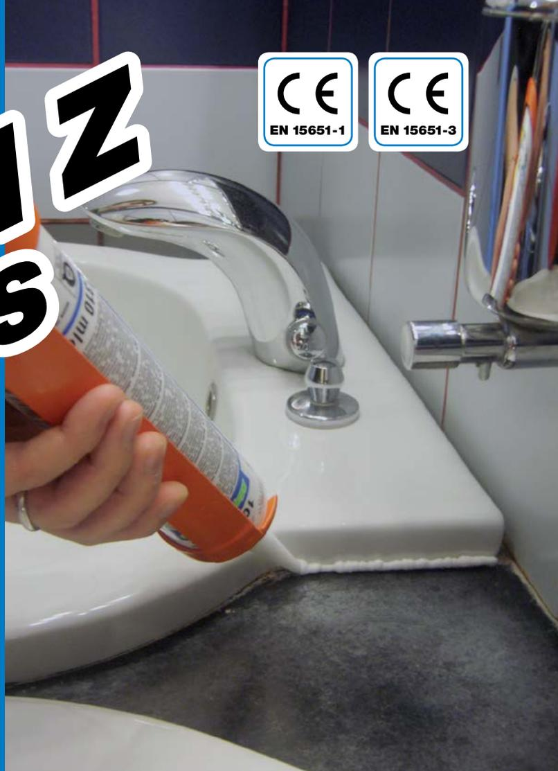
**Selante silicónico acético puro, resistente ao bolor, para instalações sanitárias**
