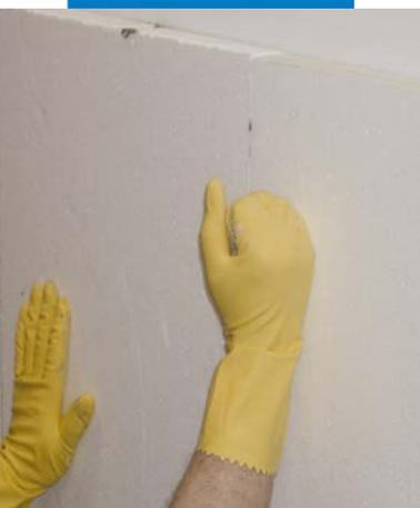
Pressionar os painéis após o assentamento para garantir a boa aderência ao suporte
