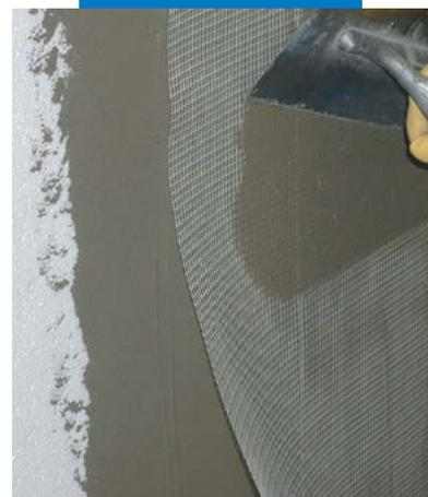
Barramento dos painéis termo-isolantes armada com rede em fibra de vidro inserida na camada de Mapetherm AR1
