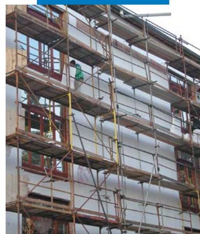
Colagem dos painéis termo-isolantes na fachada com Mapetherm AR1
