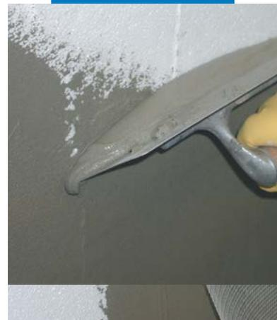
Barramento dos painéis termo-isolantes: aplicação do Mapetherm AR1
