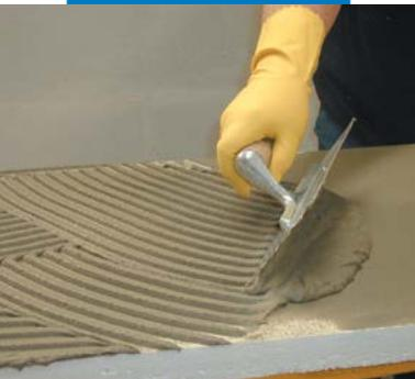
Aplicação do Mapetherm AR1 no reverso do painel com espátula dentada
