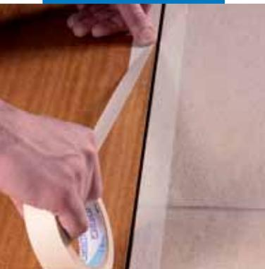
Aplicação da fita de papel protetora para a selagem da junta
