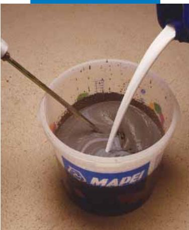
Mistura de **Planipatch** com **Latex Plus** para regularização sobre suportes difíceis e deformáveis
