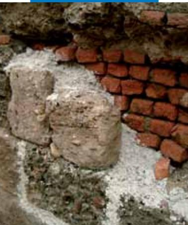
Reconstrução de uma alvenaria com uma argamassa confeccionada em obra
