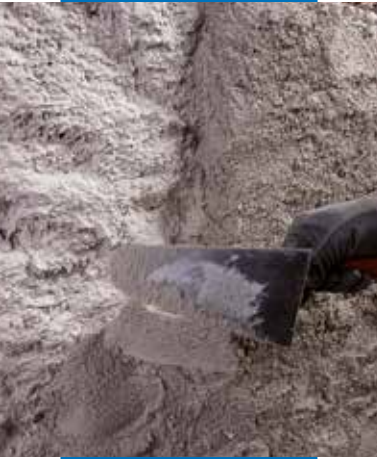
Applying Mape-Antique MC over Mape-Antique Rinzafo
