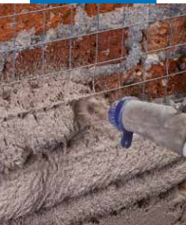
Spray-application of Mape-Antique Strutturale NHL
