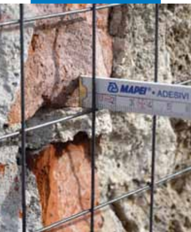
Verificação da distância entre a rede e o suporte
