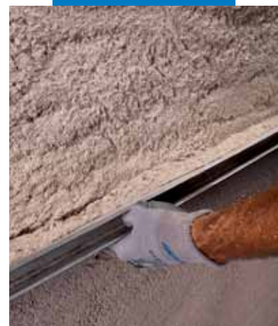
Nivelamento à regua de Mape-Antique Strutturale NHL
