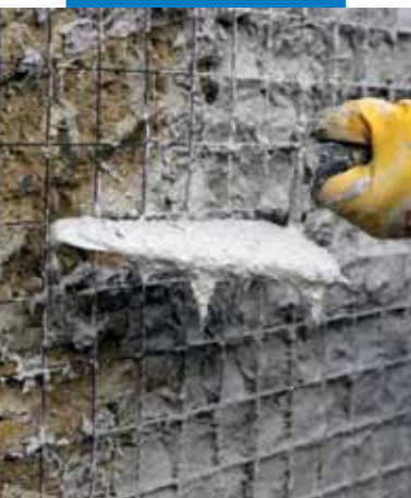
Aplicação de Mape-Antique Rinzafo na alvenaria mecanicamente débil
