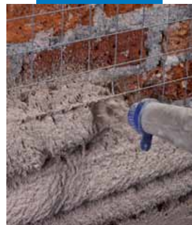
Aplicação por projeção de Mape-Antique Strutturale NHL
