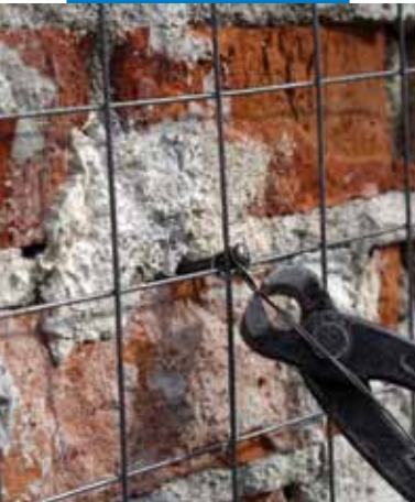
Fixação da rede zincada à alvenaria
