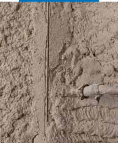
Aplicação do Mape-Antique MC Macchina
