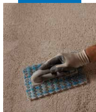
Acabamento do Mape-Antique MC Macchina
