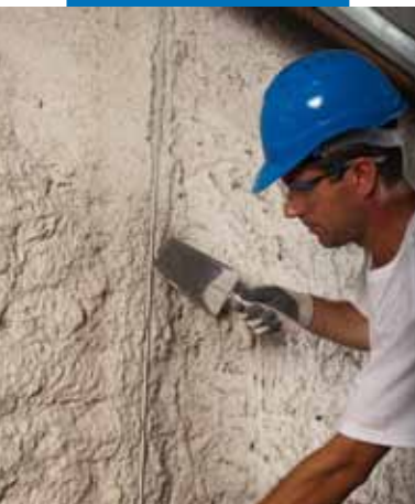
Posicionamento de uma guia vertical
