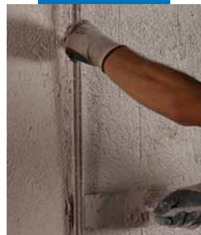
Remoção de uma guia vertical
