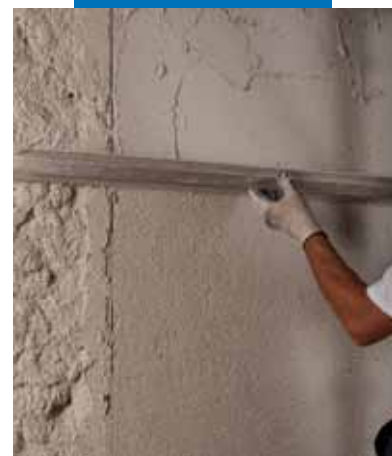
Nivelamento do Mape-Antique MC Macchina
