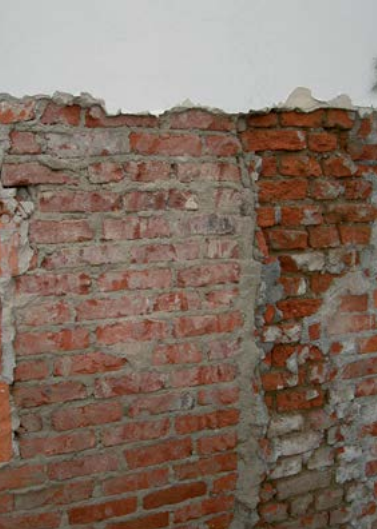
Alvenaria após a remoção do reboco
