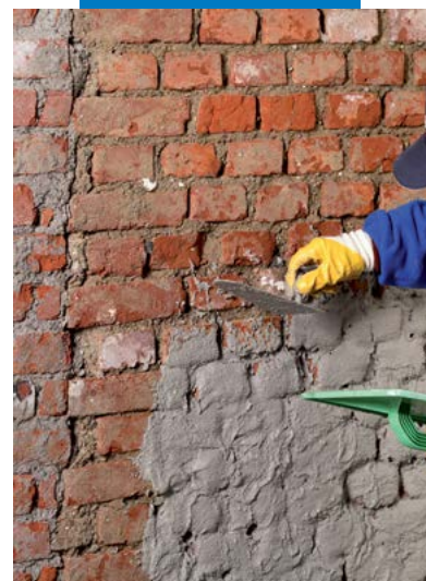
Aplicação de PoroMap Rinzaïffo com colher de pedreiro
