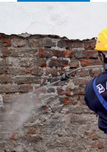
Hidro lavagem da alvenaria
