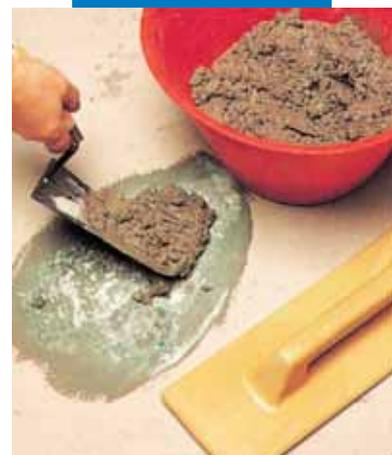
Reparação de pavimento: aplicação de argamassa
