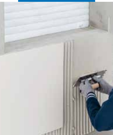
Assentamento de ladrilhos cerâmicos de grande formato
