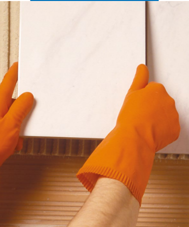
Assentamento do revestimento em parede
